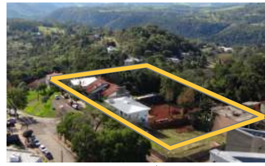
Imagem 29: Marcação da área de intervenção
