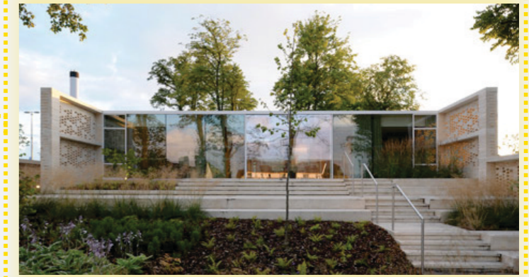
Imagem da fachada de fundos, com acesso ao jardim. Disponível em: www.dezeen.com/2014/10/20/reiach-and-hall-architects-maggies-centre-lanarkshire-walled-gardens/ . Acesso: 23/05/2015.
