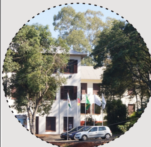
05. Instalações provisórias da UFFS no Seminário Nossa Senhora de Fátima
