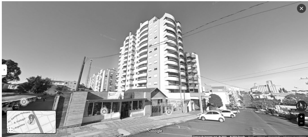
Figura 2 - Imagem de um edifício localizado na Rua Argentina
