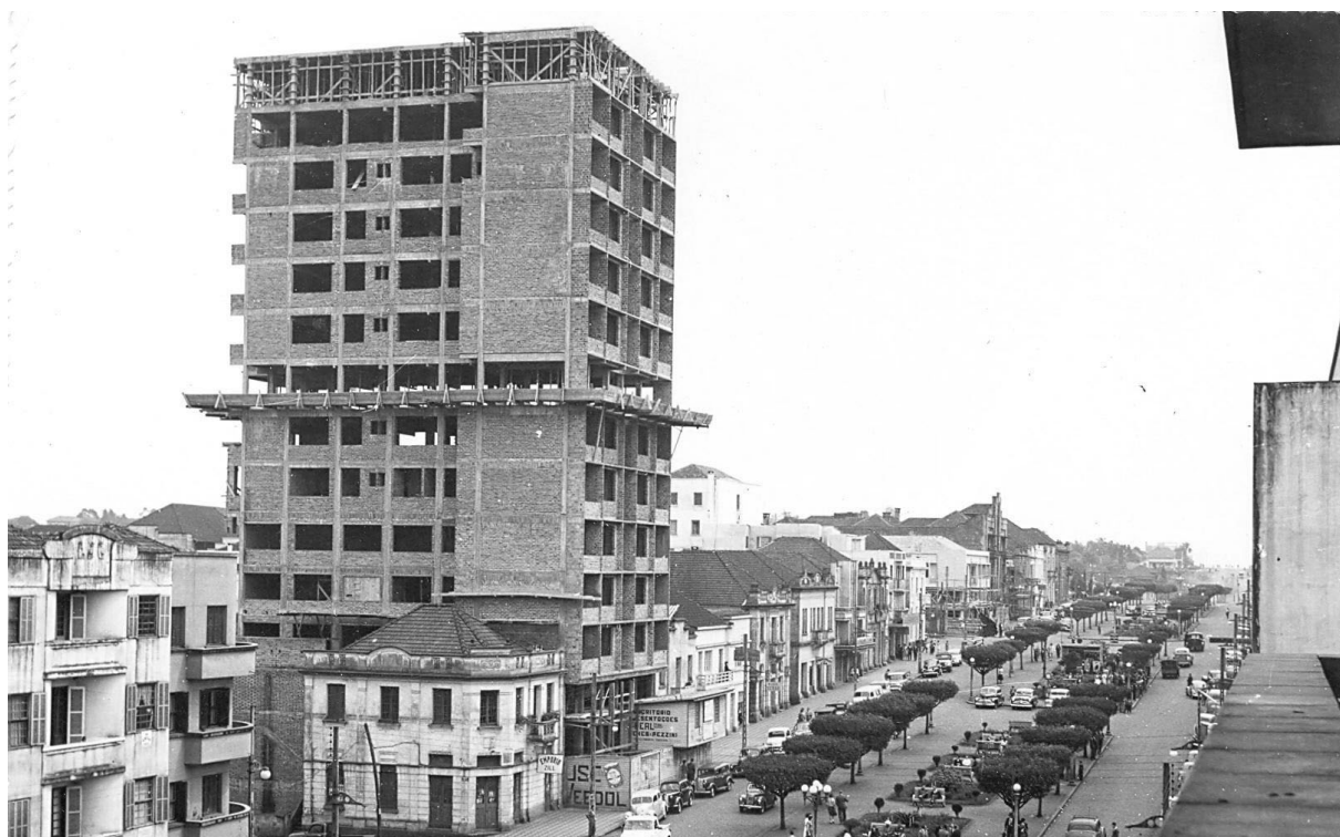
Figura 11 - Construção do Condomínio Erechim na década de 1950
