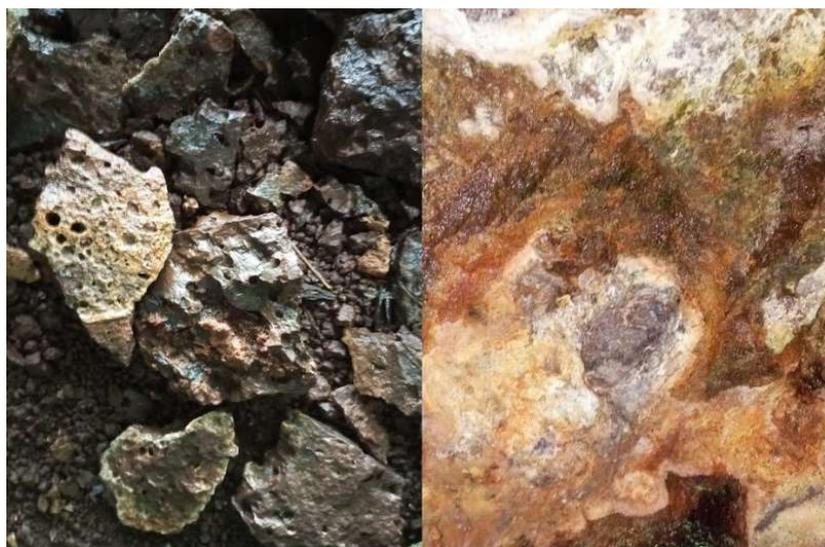
*Fotografia 8: A esquerda: material despreendido/ A direita: descamações nas paredes laterais.*
