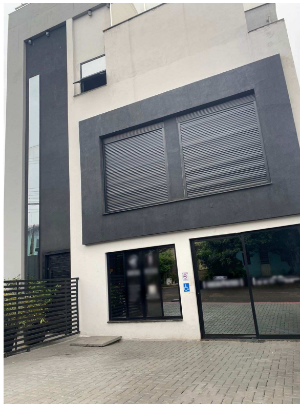
Figura 6 - Exterior da sala comercial
