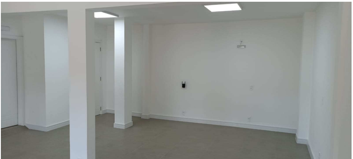
Figura 8 - Interior da sala comercial, espaço destinado ao estoque e operação
