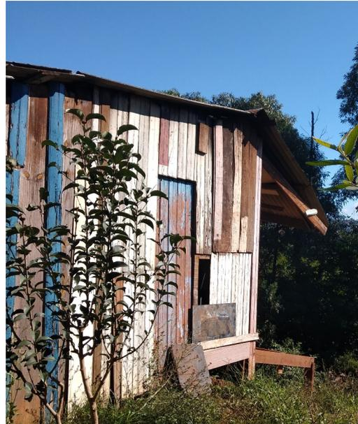
Fotografia feita em trabalho de campo (11/05/2023). Pequena moradia construída com fragmentos de madeira. Estrutura precária, sem ventilação e iluminação, sem acesso à energia, água tratada e esgotamento sanitário.
