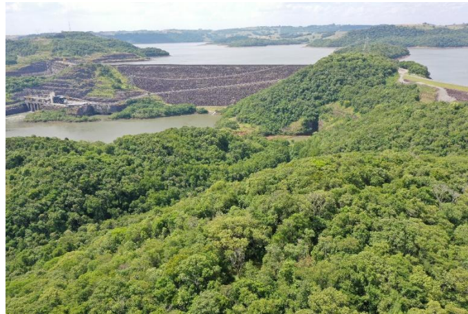
Figura 20. Foto aérea mostrando a cobertura vegetal próximo a repetidora.
