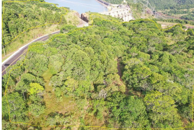
Figura 14. Trecho junto a jusante do barramento, na margem direita, próximo ao Rio Uruguai.
