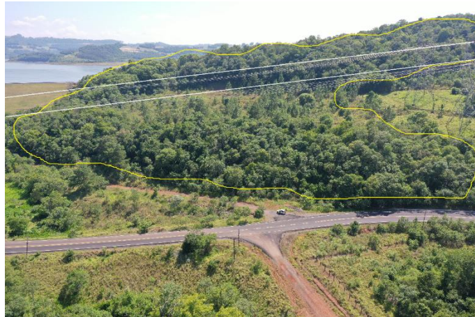
Figura 18. Foto aérea mostrando a cobertura vegetal na margem esquerda da RS 135, próximo ao dique 02.
