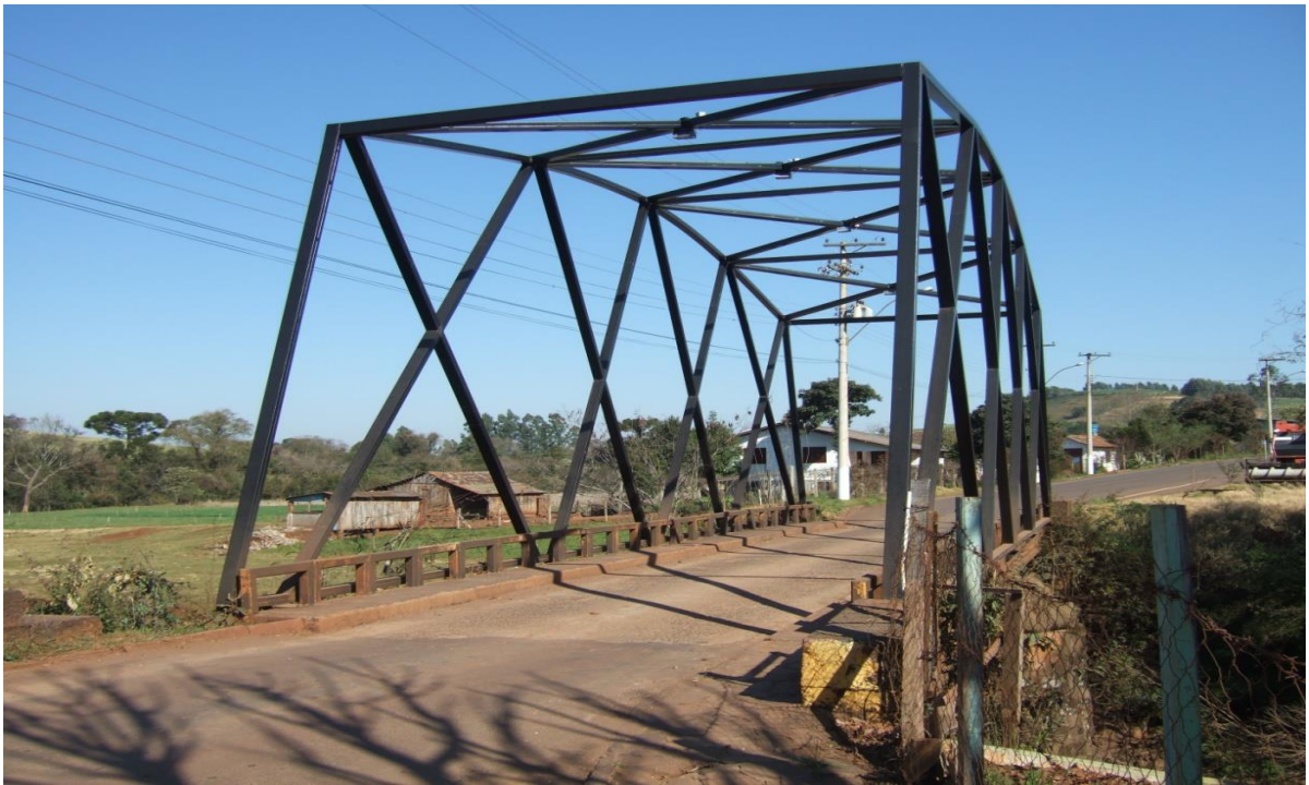
Fotografia 02 - Ponte Atual sobre o Rio Jupirangava em Ponte Preta – RS
