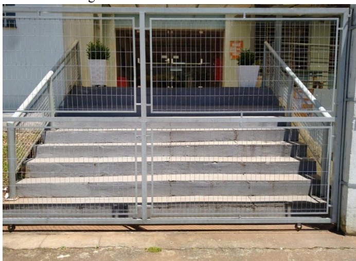
Figura 4 - Escada da entrada da escola
