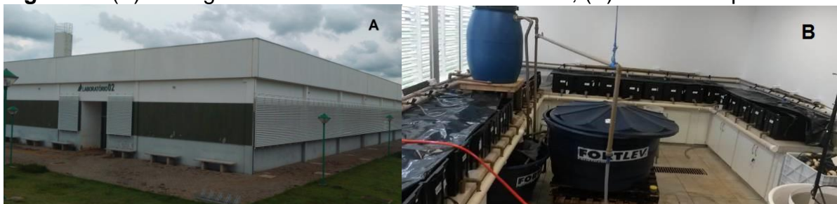
Figura 4 - (A) Vista geral do bloco de Laboratórios/UFFS; (B) Sistema experimental.
