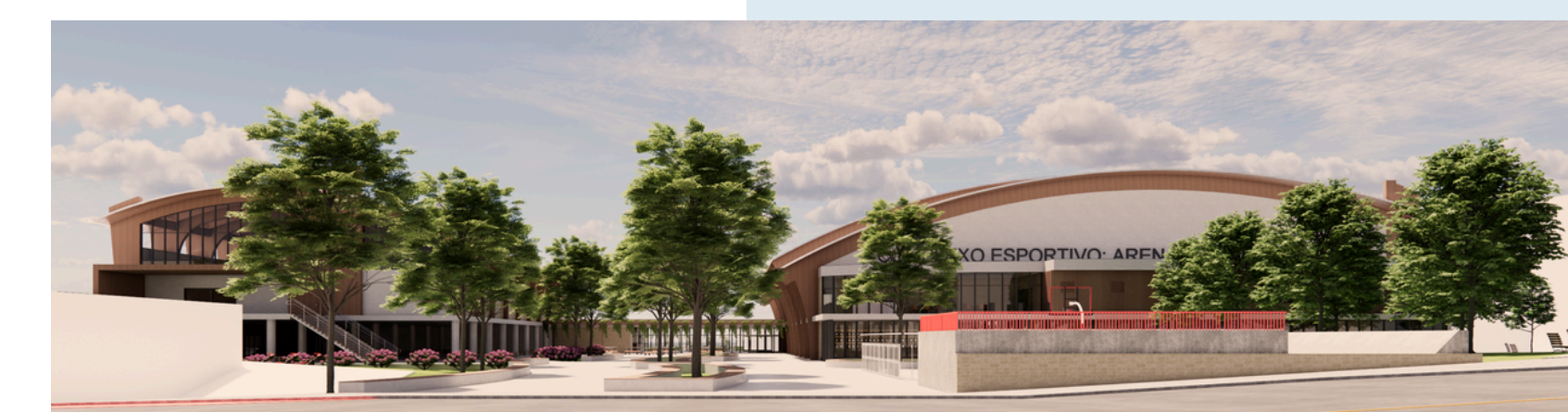
FIGURA 32: FACHADA SUL DO COMPLEXO ESPORTIVO
