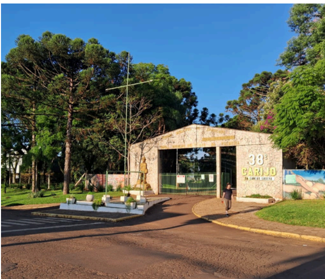
Acesso principal. Avenida Sete de Setembro.
