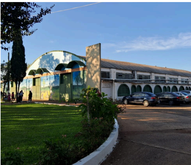
Galpão de eventos.
