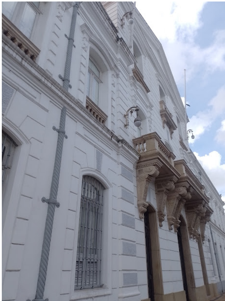
Figura 6 - Foto registrada da fachada do Palácio
