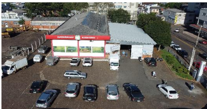
Figura 14 - Pavilhão da antiga filial da Feira da Agricultura Familiar e Supermercado em Erechim-RS
