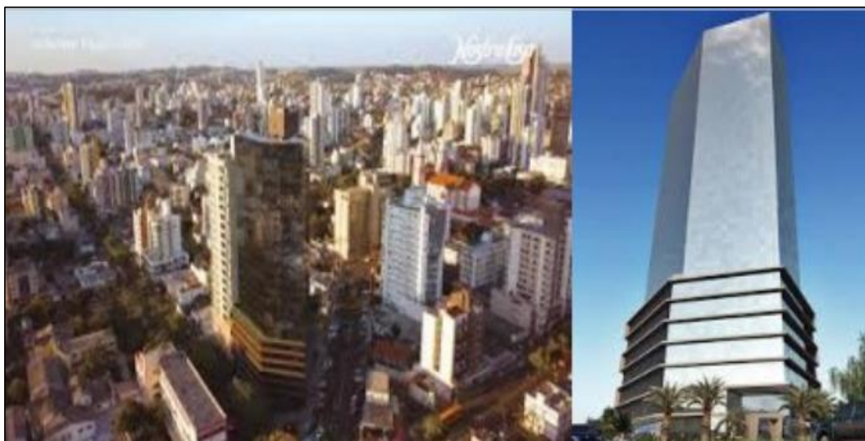
Figura 26: Vista do edifício II Centenário – uso comercial e empresarial, centro de Chapecó
