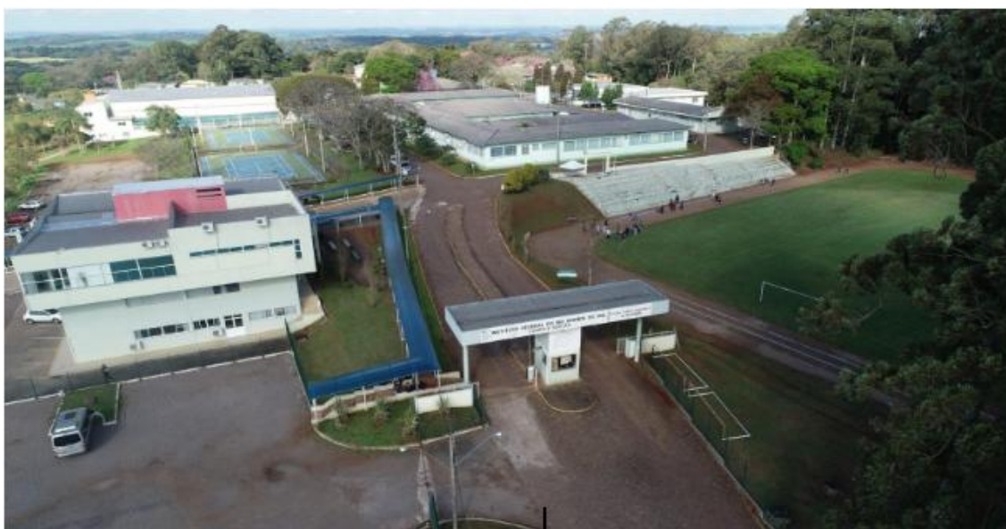
Foto 1 - Vista aérea do Instituto Federal do Rio Grande do Sul Campus Sertão .
