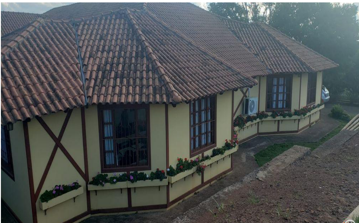
Figura 11: Vista parcial do prédio da CFR de Iporã do Oeste.
