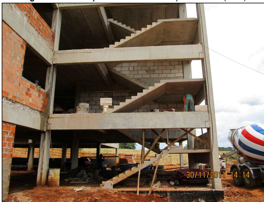
Figura 10: Construção do Bloco A no Campus Erechim (2011)
