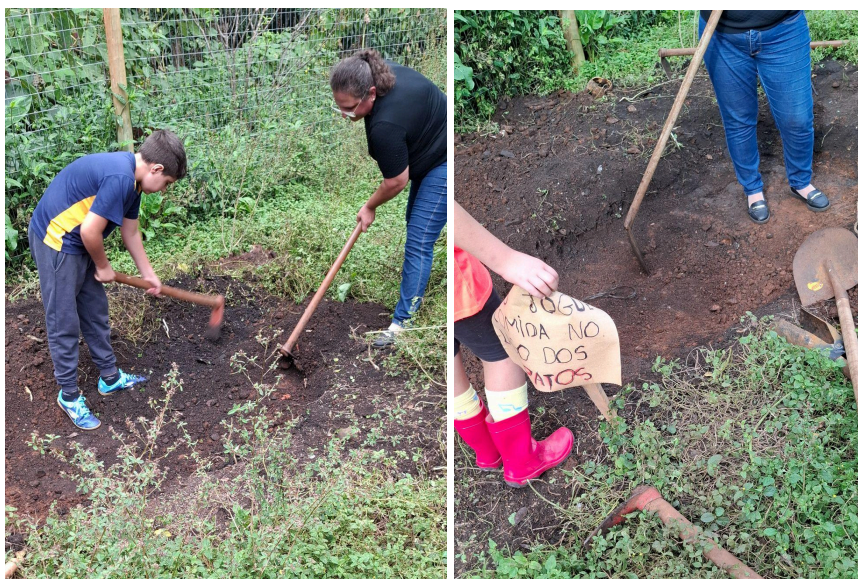
Construção Lago dos Patos - Arquivo pessoal, 2026.
