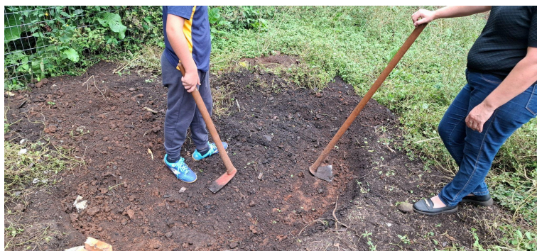
Construção Lago dos Patos - Arquivo pessoal, 2026.
