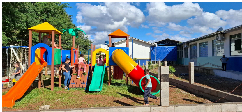
Parque da escola em reforma - Arquivo pessoal, 2026.
