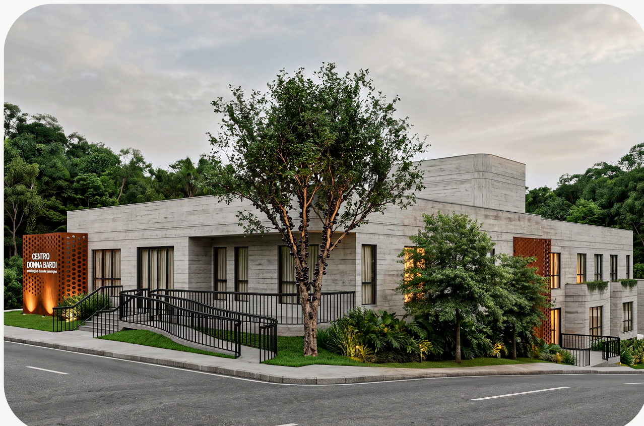
IMAGEM 17 Vista da edificação pela esquina das ruas Danúzia Bess e Coronel Lucidoro.
