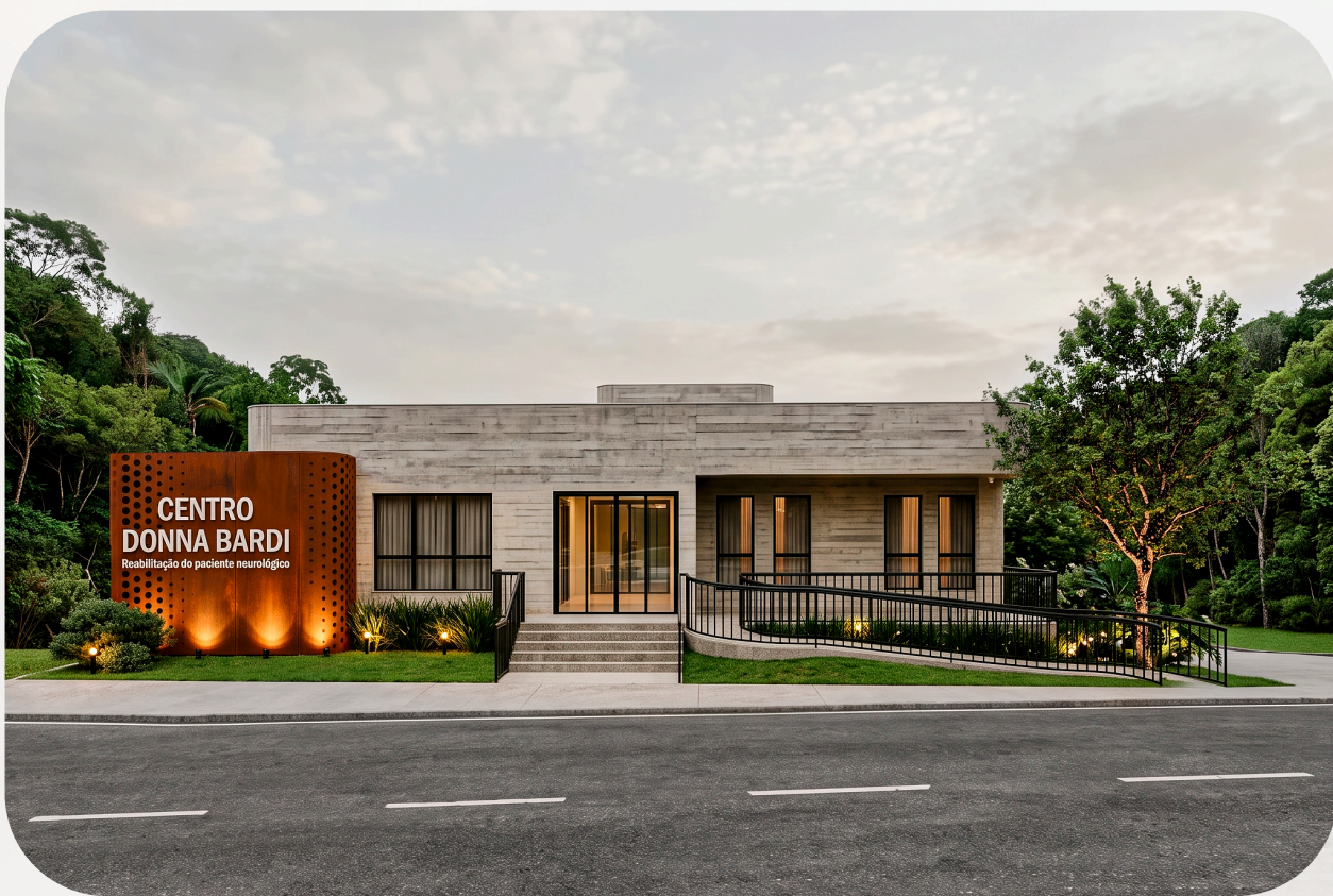
IMAGEM 18 Vista da edificação pela rua Danúzia Bess.
