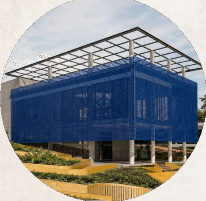
Figura 25: Chapa Metálica perfurada no auditório
