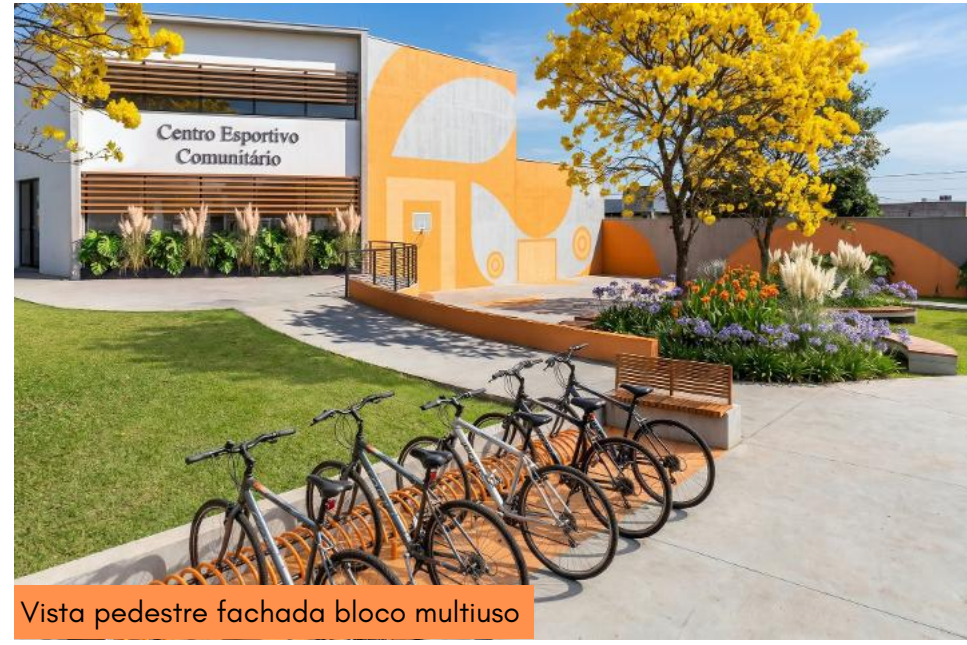
Vista pedestre fachada bloco multiuso
